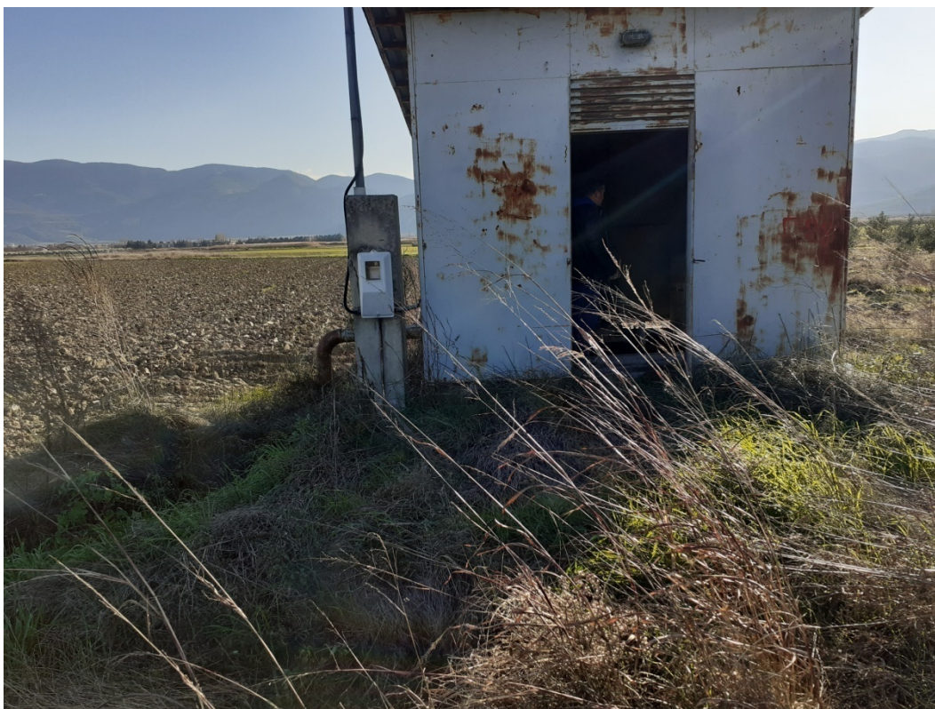
Εικ. 3. Άποψη από τη γεώτρηση στη θέση «Λυκοχώρια».
