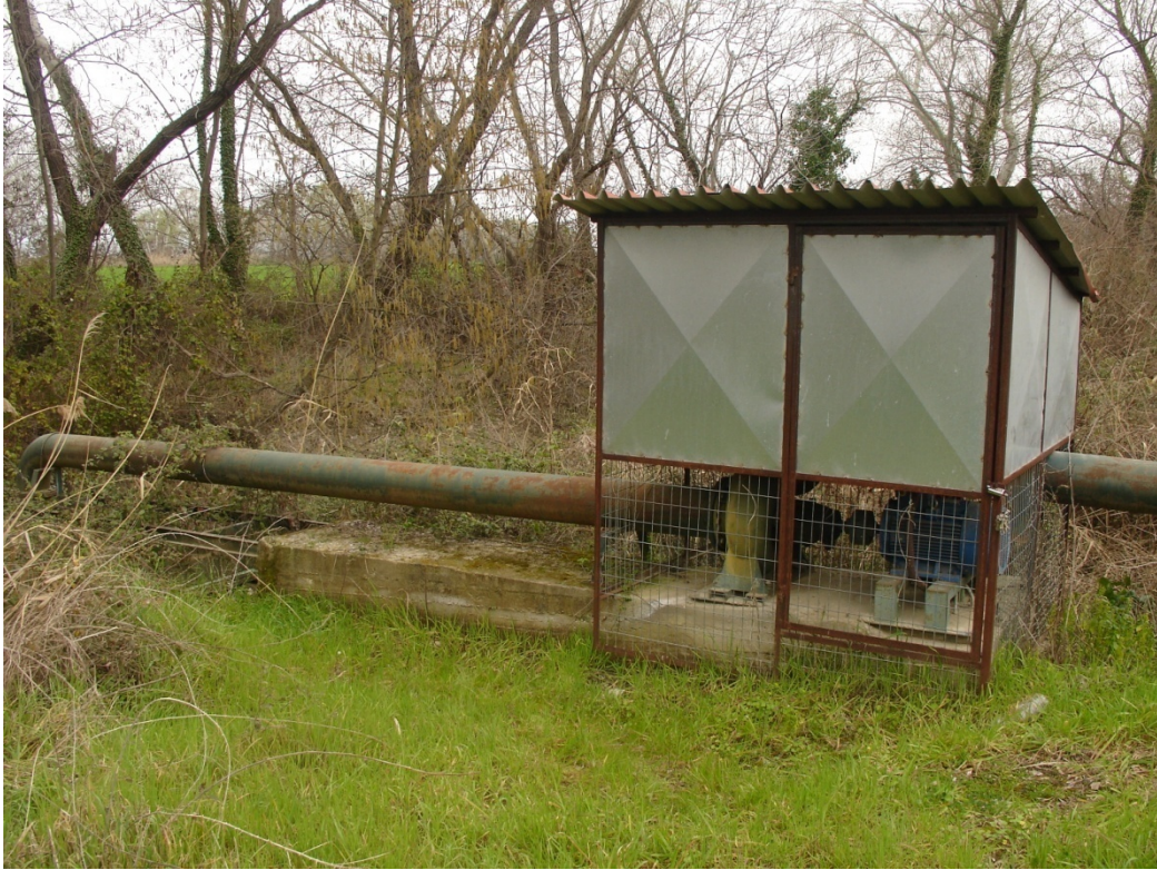
Εικ. 1. Άποψη από το επιφανειακό αντλιοστάσιο στον Σπερχειό (Ημερ.: 2/03/2013).
