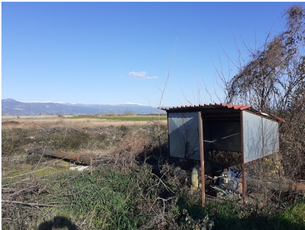
Εικ. 2. Άλλη άποψη από το επιφανειακό αντλιοστάσιο στον Σπερχειό (Ημερ.: 20/01/2020).
