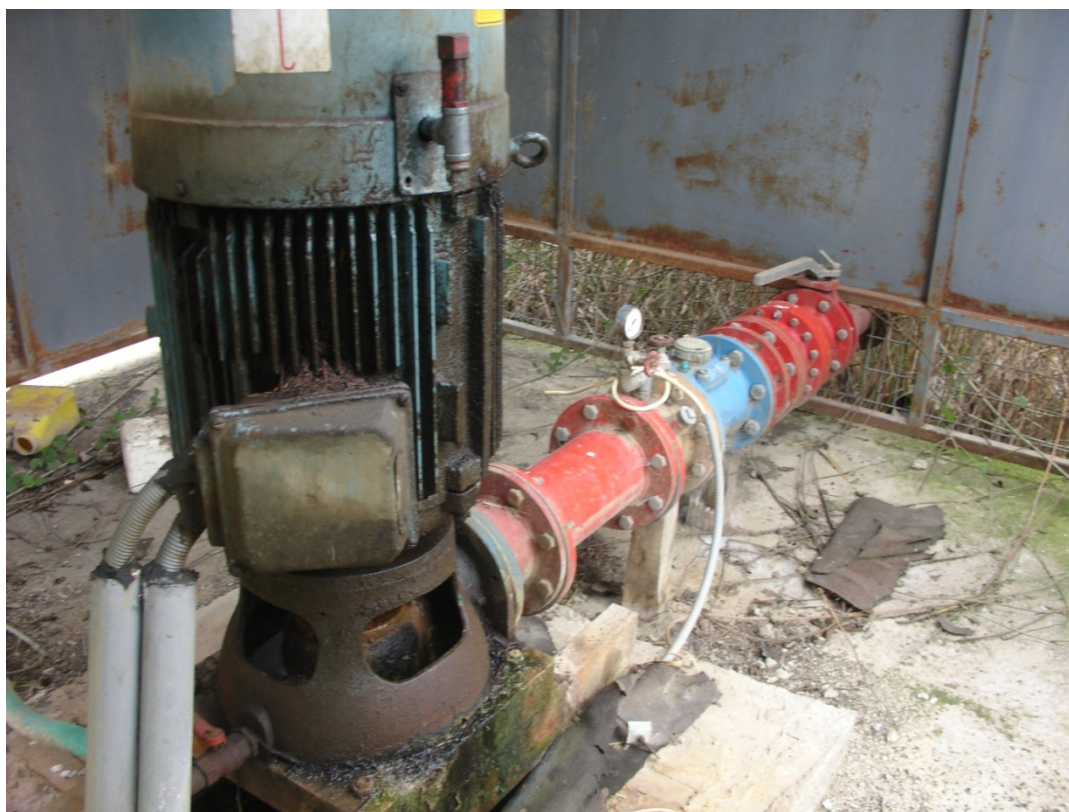
Εικ. 6. Άποψη από το εσωτερικό της γεώτρησης στη θέση «Αγία Κυριακή».
