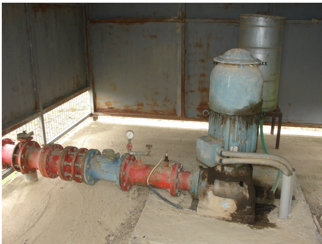
Εικ. 4. Άποψη από το εσωτερικό της γεώτρησης στη θέση «Λυκοχώρια».
