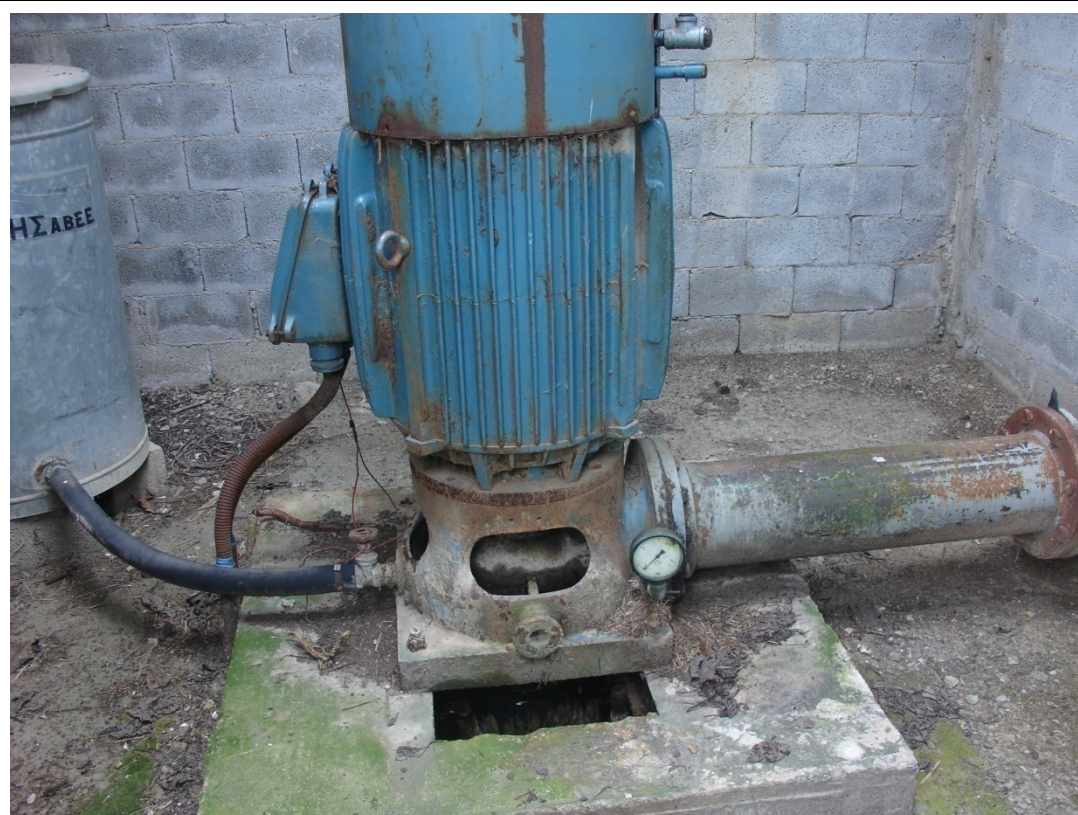
Εικ. 10. Άποψη από το εσωτερικό της γεώτρησης στη θέση «Λειβαδάκια».
