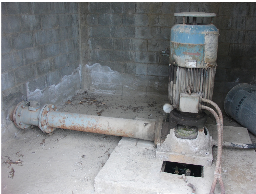
Εικ. 8. Άποψη από το εσωτερικό της γεώτρησης στη θέση «Καΐκια (Καραναστιάση)».
