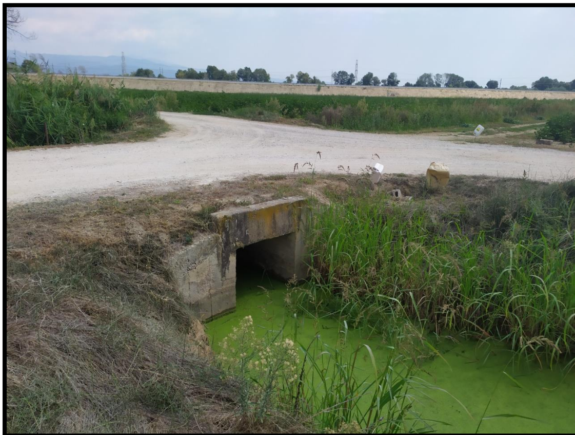
Φωτογραφία 3: Υφιστάμενος Κιβωτοειδής Οχετός (Κόμβος Κ5)
