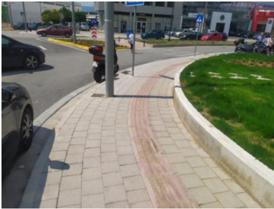
Εικόνα 12: Οδηγός όδευσης τυφλών επί της οδού Θερμοπυλών (αρχείο αυτοψίας)
