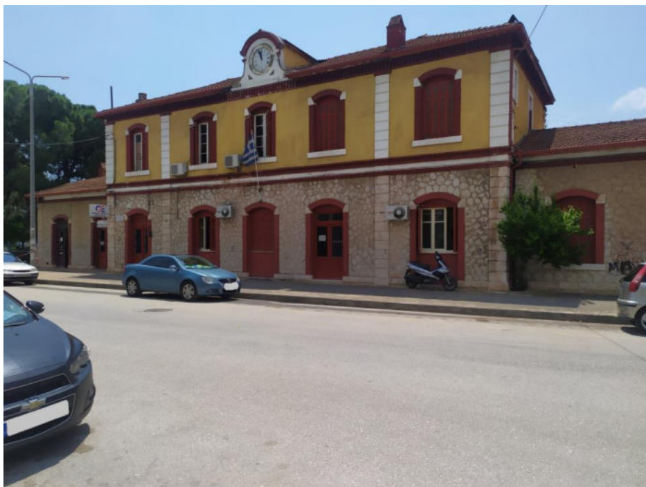
Εικόνα 18: Σιδηροδρομικός Σταθμός Λαμίας επί της οδού Κωνσταντινουπόλεως (αρχείο αυτοψίας)
