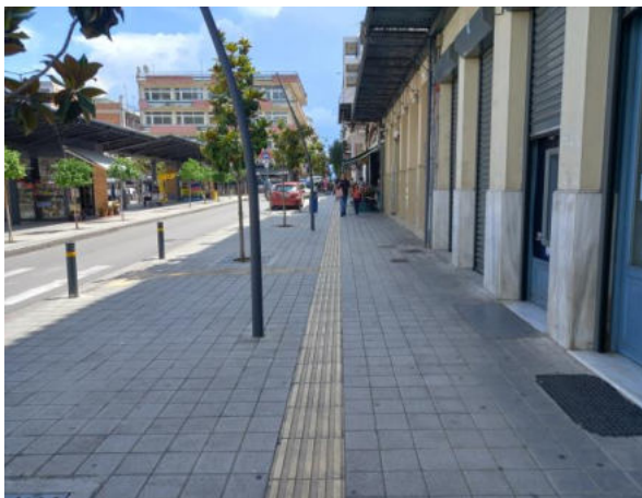
Εικόνα 14: Οδηγός όδευσης τυφλών επί της οδού Πλ. Πάρκου (αρχείο αυτοψίας)
